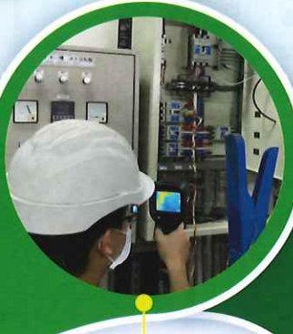
電力盤熱點量測
